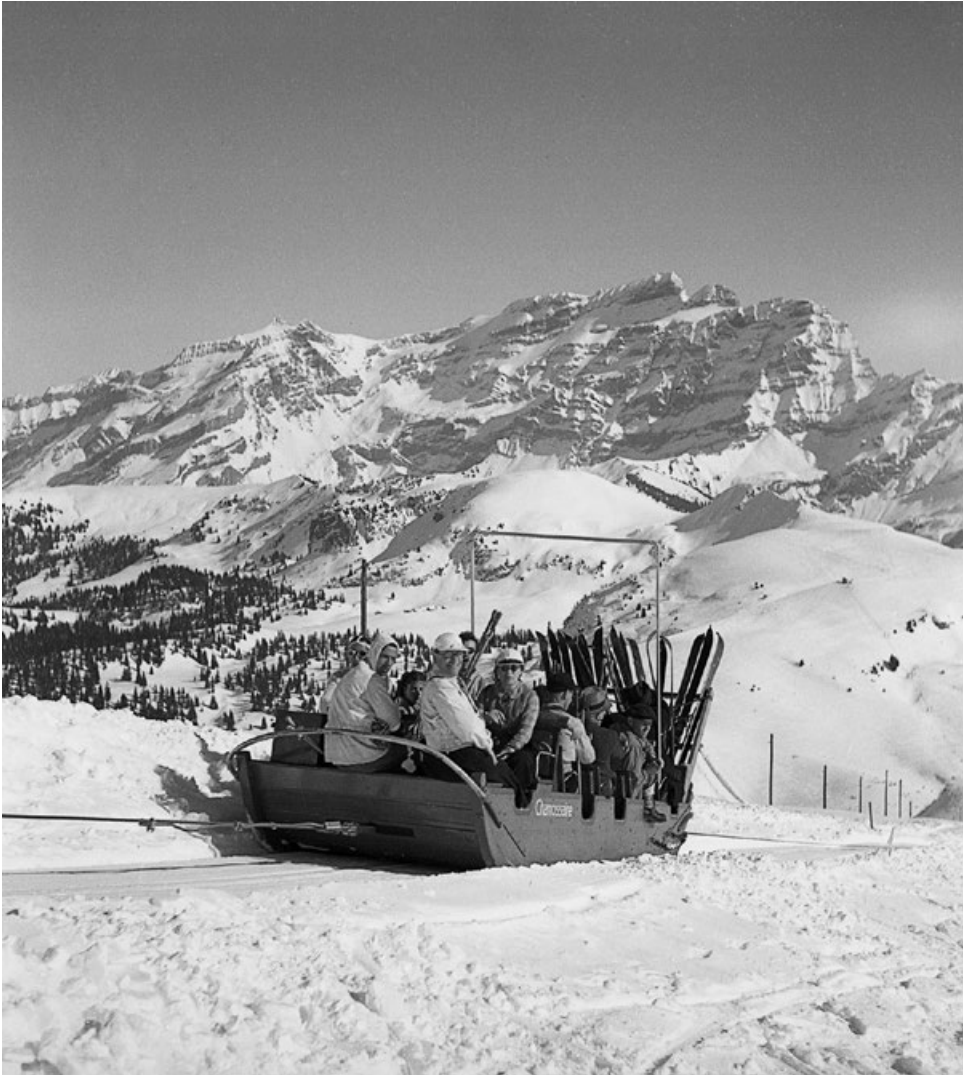
Villars-sur-Ollon, Grand Chamossaire. Funiluge tracté par un câble avec des skieurs, 1938, photographe: Max Émile Jean Kettel, Ville de Genève, Bibliothèque de Genève (ket n06x06 a 7 35)
